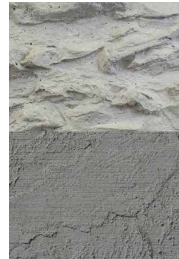
BETONoberfläche Durch verschiedene Matrizeschalungen individuell nach Wunsch
