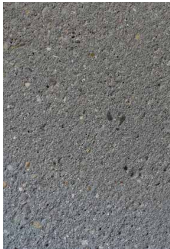
BETONoberfläche Sand gestrahlt
