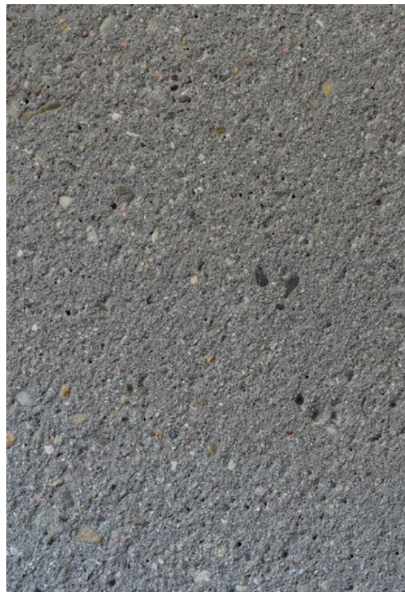
BETONoberfläche Sand gestrahlt
